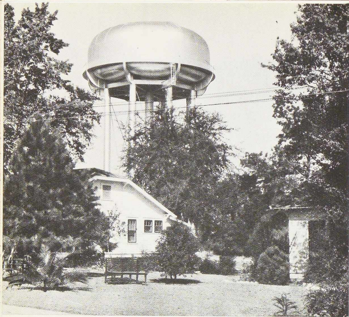
Fig. 24. Château d'eau à Tallahassee, Floride. Capacité 1.515 m 3 . Le réservoir est supporté par 8 piliers tubulaires.
