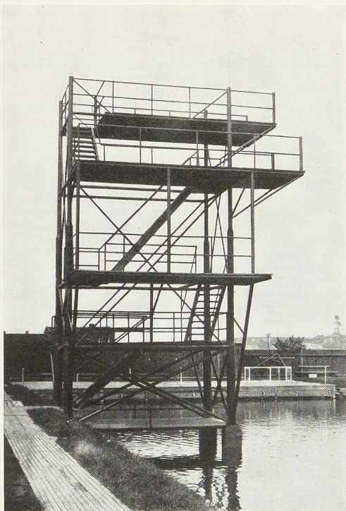
Fig. 14. Plongeoir en tubes soudés, à Szarłoj, Pologne.
