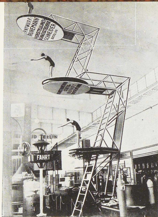
Fig. 13. Plongeoir en tubes soudés construit à Berlin en 1931.
