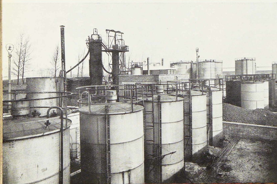
Fig. 44. Tanks à mazout de la Belgian Cracking Company à Langerbrugge. - Constructeur : Chaubel.
