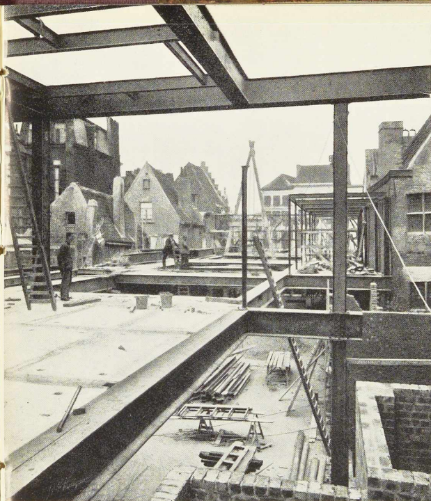
Fig. 682. Vue de la charpente métallique en construction du magasin « Priba », prise du premier étage. On remarquera la charpente de la galerie couverte et les couvertures de la toiture vitrée du rez-de-chaussée.
