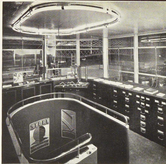
Fig. 715. Un escalier métallique conduit au premier étage du stand, dont le mobilier, les châssis de fenêtres, les mains courantes et le plafond sont en acier.
