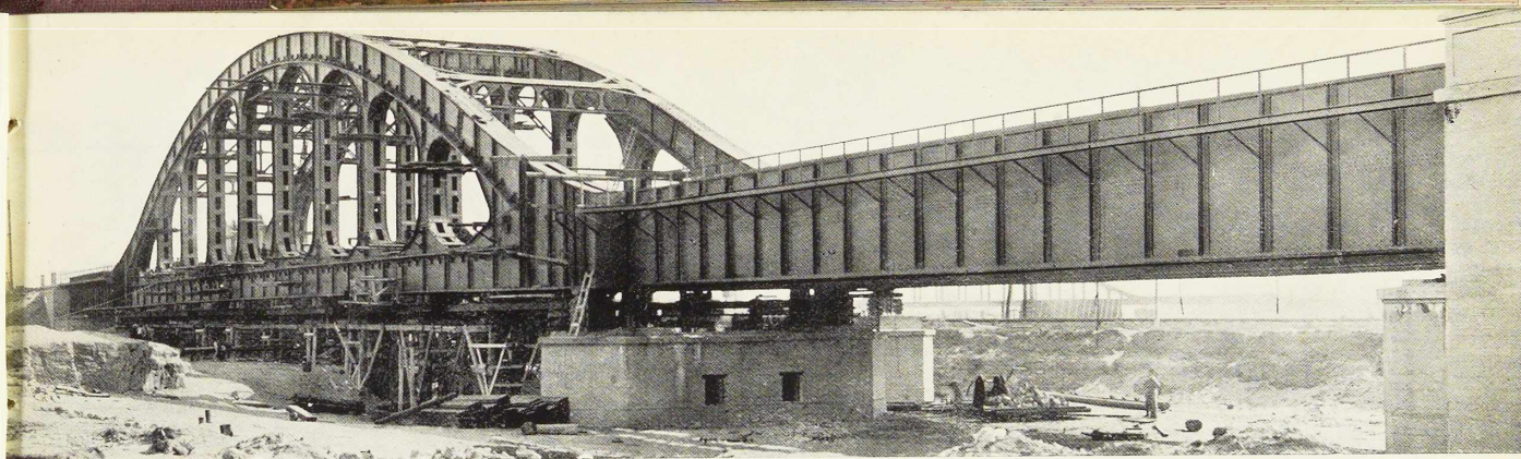
Fig. 611. Le pont de chemin de fer sur le canal Albert à Hérenthals. Ce pont à double voie comporte une travée centrale à poutres Vierendeel de 89 m 54 de portée et de deux travées d'approche en poutres à âme pleine de 33 m 20 de portée chacune. Ce pont partage avec le pont de Malines décrit ci-après le record de la portée pour les poutres Vierendeel.
