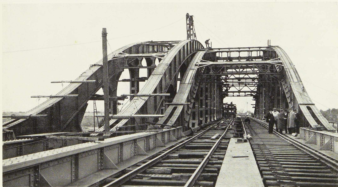
Fig. 623. Vue d'enfilade du pont-rail double d'Hérenthals après achèvement du montage. A noter dans le contreventement supérieur, d'une part les entretoises doubles en poutres Vierendeel, d'autre part les bracons formant larges goussets évidés aux extrémités de ces entretoises, qui ont été substitués aux habituelles croix de Saint-André et qui contribuent très efficacement à raidir contre le flambage les brides supérieures des maîtresses-poutres.
