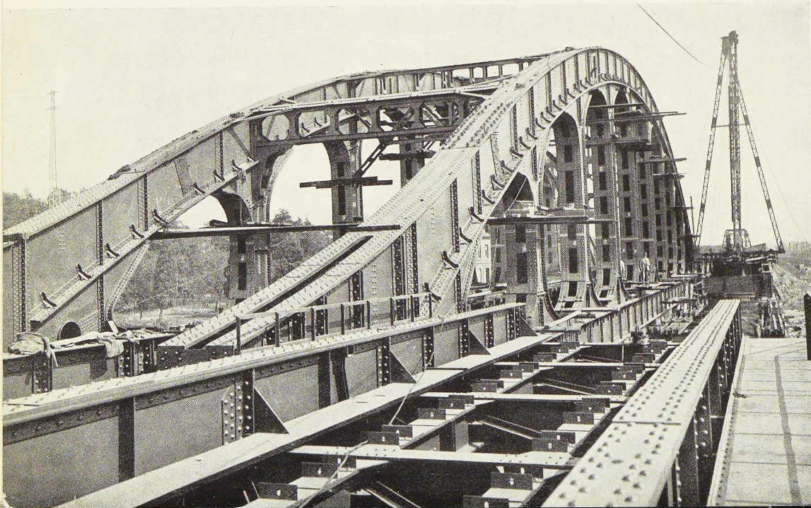
Fig. 621. Vue de la travée centrale du pont à double voie d'Hérentals, prise du tablier du pont à simple voie en cours de montage.
