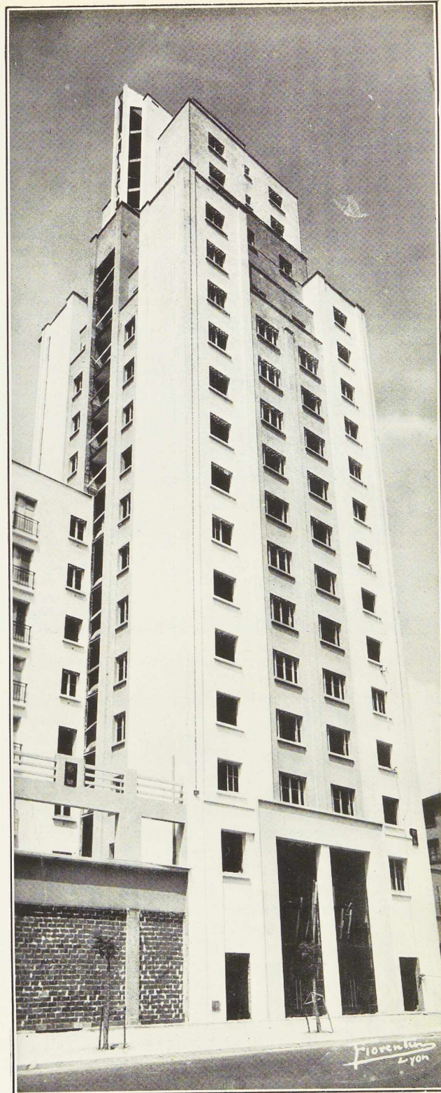
Fig. 599. Une des tours d'entrée : elles comportent 19 étages et une terrasse accessible. (Cliché Construction Moderne.)
