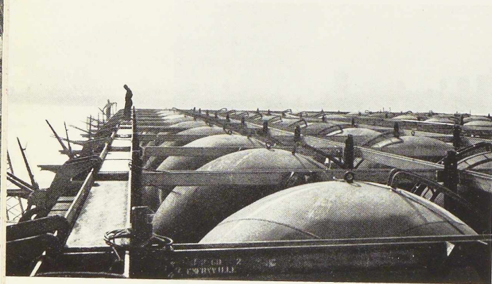
Fig. 637. Vue générale des 55 calottes sphériques fermant les puits de la pile centrale.
