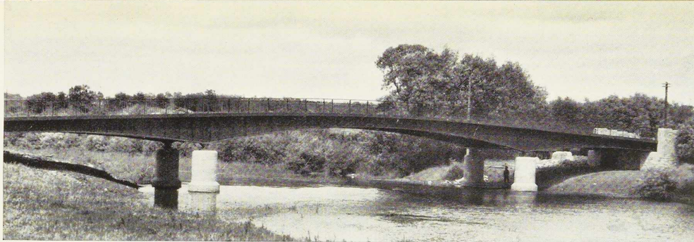
Fig. 579. Le pont de Fladbury sur l'Avon comporte 3 travées dont les portées respectives sont de 15 m 25, 30 m 50 et 15 m 25. Les 2 poutres principales cantilever sont distantes de 7 m 10 d'axe en axe et supportent une travée suspendue centrale de 10 m 45. La fondation des piles en rivière est constituée par des cylindres en acier de 3 m 65 de diamètre foncés jusqu'à 3 m 50 dans l'argile bleue compacte, puis remplis de béton.
