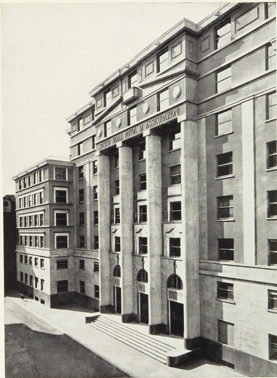
Fig. 510. Façade principale sur la Corte d'Appelo.
