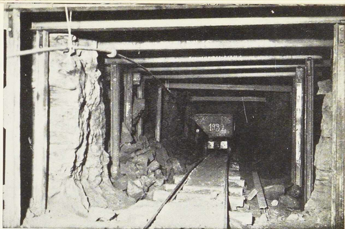
Fig. 533. Vue d'une galerie de mine dont le soutènement est exécuté en poutrelles Grey.
