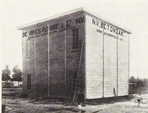
Fig. 556. Construction à ossature métallique d'une contenance de 900 m 3 sur laquelle des essais de résistance au feu furent effectués.
