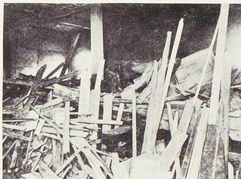
Fig. 557. Vue des matériaux combustibles entassés à l'intérieur de la construction fig. 556. Ces matériaux d'un poids de 15000 kg. étaient répartis sur 100 m 2 de plancher.
