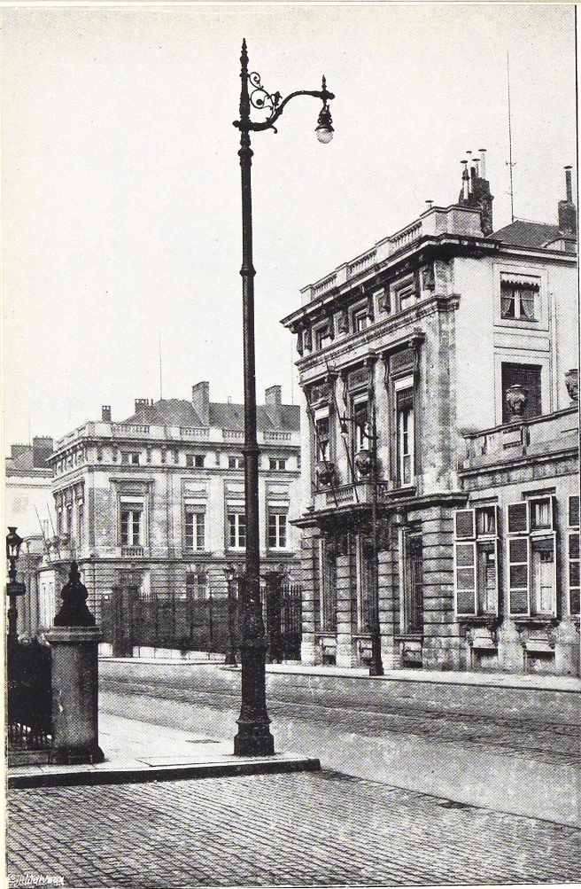
Fig. 169. Poteau métallique en tube d'acier utilisé comme support pour l'éclairage des voies publiques.
