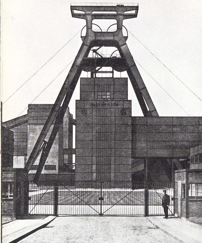
Fig. 196. Vue d'un chevalement en arc à deux rotules à la mine « Zollverein 12 » La construction en treillis habituelle a été remplacée par la construction à âme pleine.
