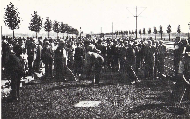
Fig. 204. Visite de la route en acier à Dusseldorf organisée le 6 septembre 1933 par la Studiengesellschaft für den Bau von Stahlstrassen à Dusseldorf. Comme on le voit, une grande affluence de visiteurs s'est intéressée à ce nouveau système de revêtement de routes.
