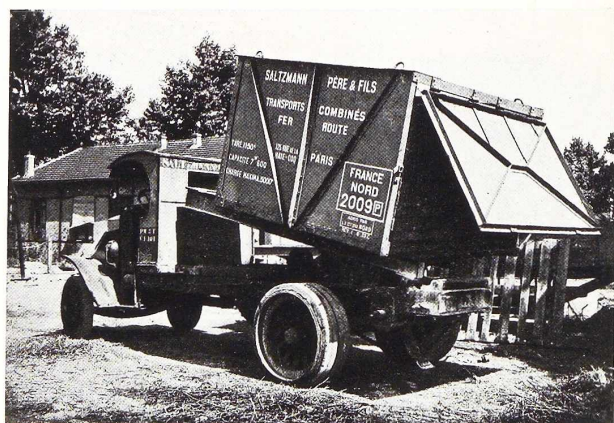
Fig. 111 et 112. Les containers métalliques sont employés dans de nombreux pays pour le transport des briques. Les containers donnent les meilleures solutions au problème des transports par rail et par route.
