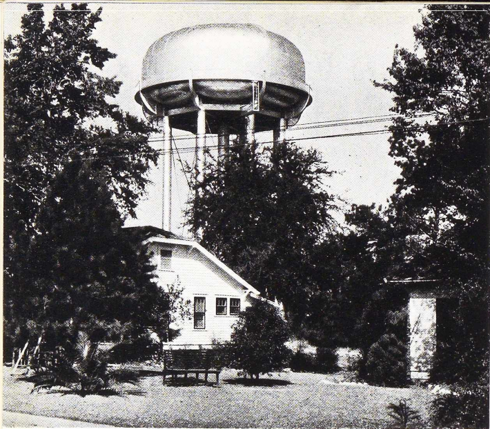
Fig. 105. Le château d'eau de Tallahassee en Floride. Sa construction dans un quartier résidentiel exigeait que l'on apportât à son architecture un soin tout particulier. Sa capacité est de 1.515 mètres cubes. Les colonnes de support sont des cylindres en tôle soudée de 85 cm. de diamètre. Elles ont 23 m. de hauteur, sans poutres de contreventement intermédiaires.
