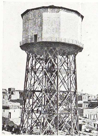
Château d'eau de 1 000 m 3 à Tintah (Egypte). Construction métallique d'avant-guerre.
