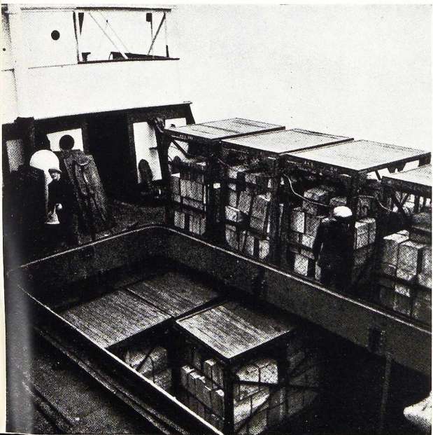
Fig. 125. Arrimage des containers à bord d'un navire de la John Cockerill Line.
