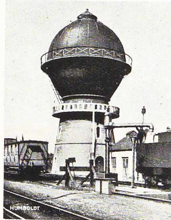
Château d'eau de la gare d'Ehrang (Allemagne). Le réservoir sphérique en acier de 750 m 3 est supporté par une tour en maçonnerie.
