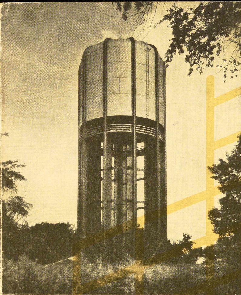
Château d'eau métallique à Baltimore.
