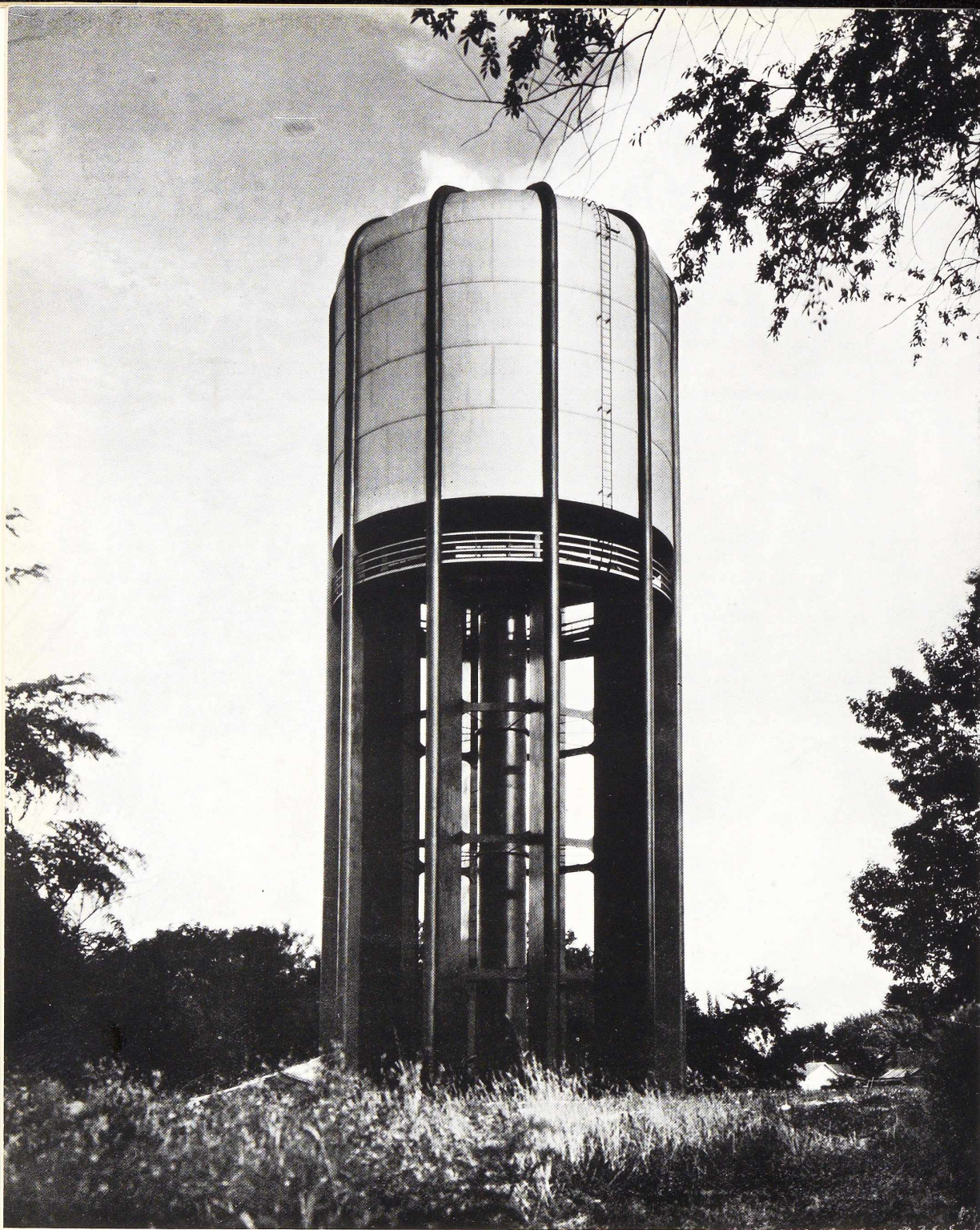
Fig. 103. Le château d'eau de Baltimore d'une capacité de 1.140 mètres cubes. Les supports en caisson sont en tôle soudée, entièrement étanches, évitant tout danger de rouille à l'intérieur. L'entretoisement des colonnes est réalisé par le balcon que l'on aperçoit au sommet et par des poutres horizontales ; on a rejeté l'emploi de toute diagonale de contreventement
