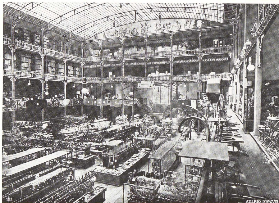
Fig. 57. Les magasins du Grand Bazar, place Saint-Lambert à Liège. Vue des magasins dans leur état primitif.
