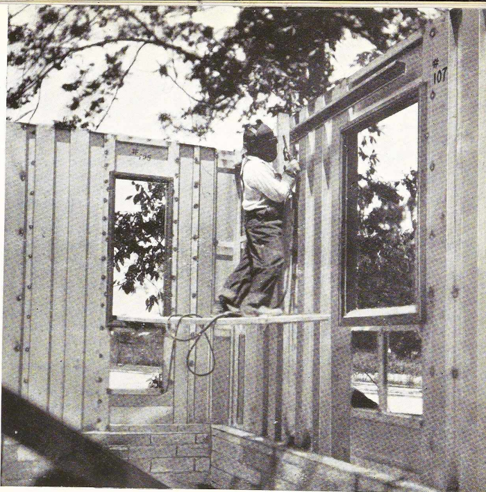
Fig. 66. Fixation par soudure de la cornière servant de support provisoire au plancher de l'étage et de conduite permanente pour les canalisations électriques.
