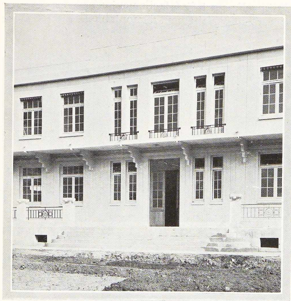
Fig. 70. Maisons métalliques. Portion de façade de l'hospice montrant l'agencement de la marquise et des consoles creuses en tôle. D'après La Technique des Travaux .
