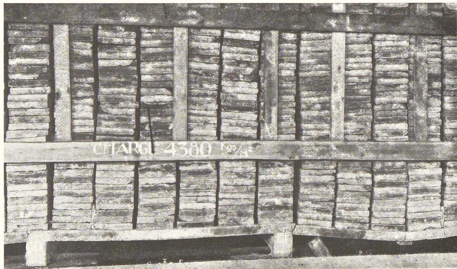
Fig. 14. Hourdis en béton de porphyre (fig. 1). Etat des dallages de la travée centrale et de la travée latérale de droite sous charge de 4.380 \text{ kg/m}^2 . L'essai a été interrompu à ce moment.
