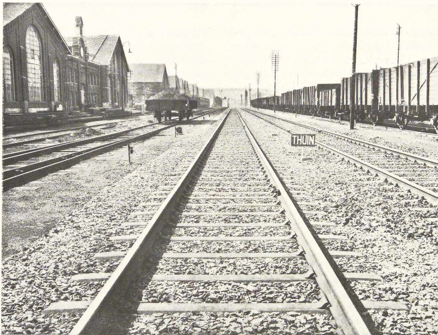
Fig. 16. Voie de chemin de fer sur traverses métalliques système Ougrée.
