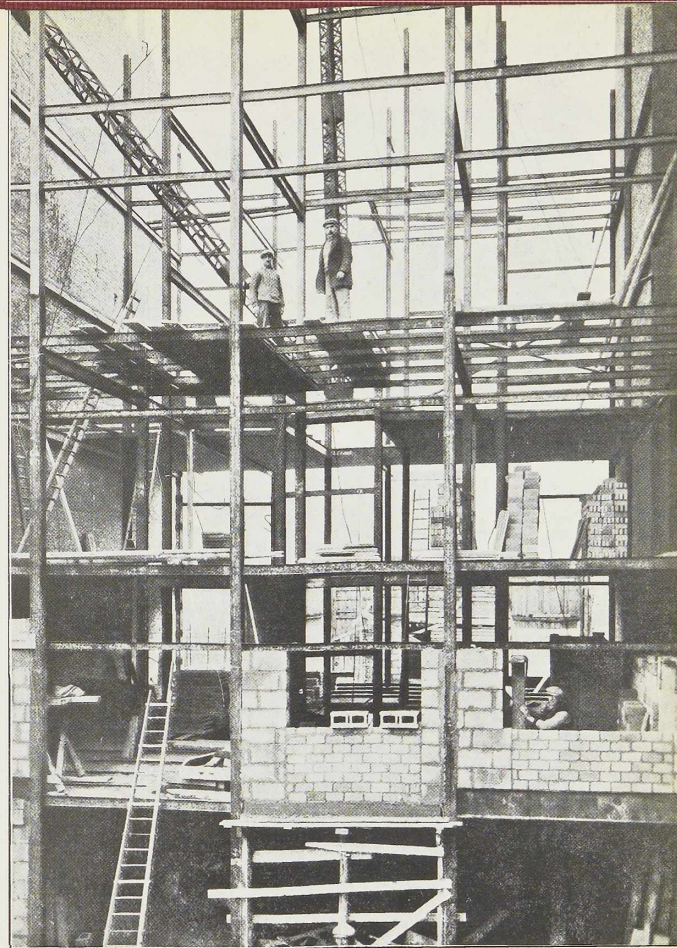
Fig. 110. Immeuble à appartements au boulevard Brand Whitlock à Bruxelles. Etat d'avancement des travaux, le 1 er décembre 1932. Vue de la façade arrière. Cliché Kemper et Günther.
