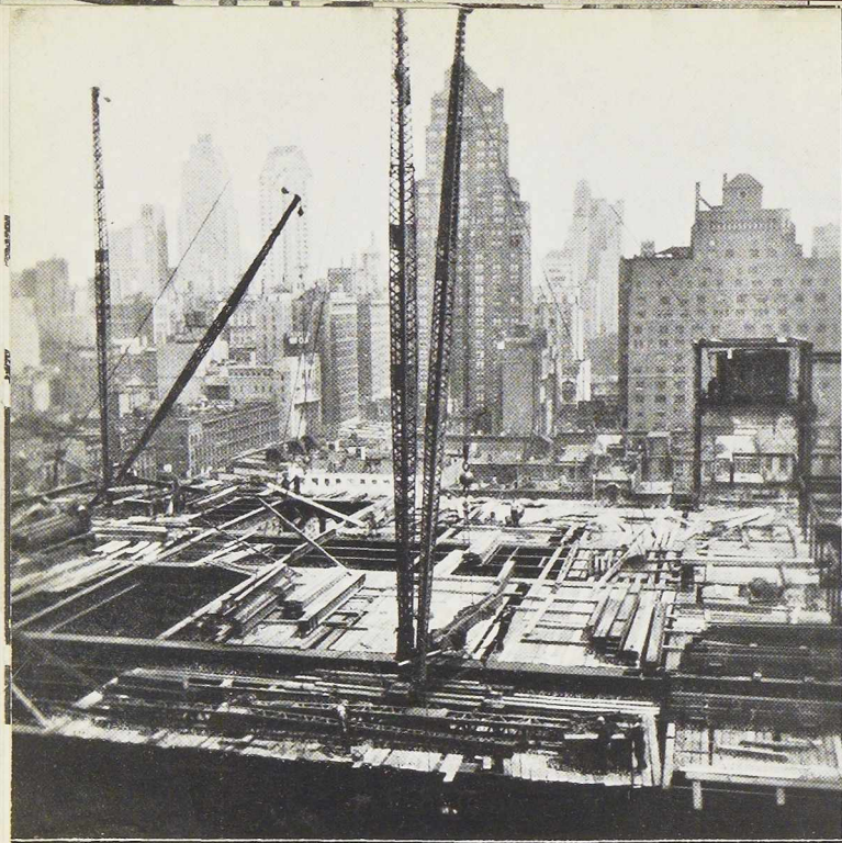
Fig. 131. Grue-derrick servant à l'érection de l'ossature métallique. Ces grues ont une capacité allant jusqu'à 50 tonnes ; la longueur de la flèche atteint jusque 36 m. La dimension des tambours des câbles limite la hauteur de levage à 33 étages. Au delà de cette hauteur on doit faire usage d'une grue-derrick de relai. A noter le plancher de travail formé de gros madriers jointifs protégeant les ouvriers occupés aux étages inférieurs. Cliché O. M.
