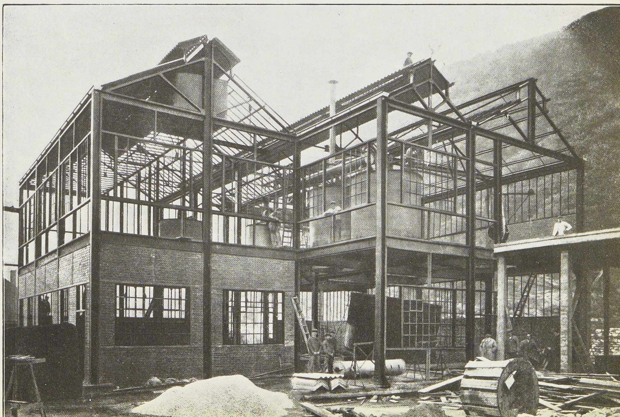
Fig. 117. Usine d'épuration des eaux de la Vesdre à Verviers Vue côté entrée. Ateliers de construction : Etablissements Delvaux Fils, Verviers. Cliché Etablissements Delvaux Fils.
