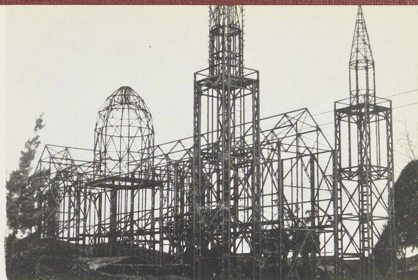
Fig. 126. Ossature en acier de l'église de San Ramon, Costa-Rica. Vue de l'ossature de l'église terminée avec les deux tours et le dôme sur le transept. Cliché Technische Blätter.
