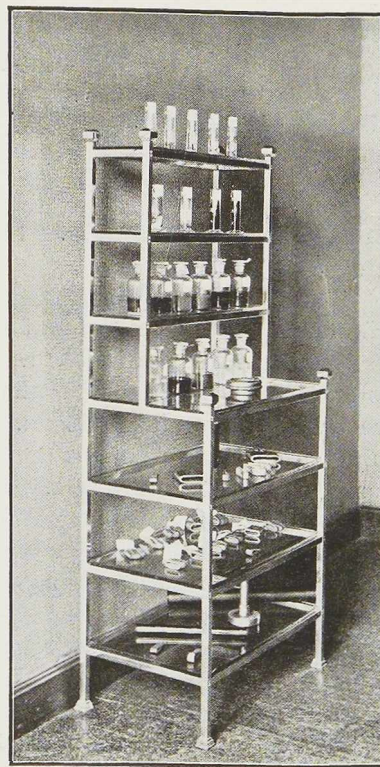
Fig. 64. Etagère en tubes carrés et dalles en verre. Construits par la firme Simon-Mottart, Seraing. Les tubes ont été fournis par la S. A. des Tubes de la Meuse, à Flémalle.
